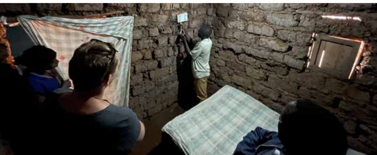
Vorstellung der Technik im Schlafzimmer eines der Häuser
