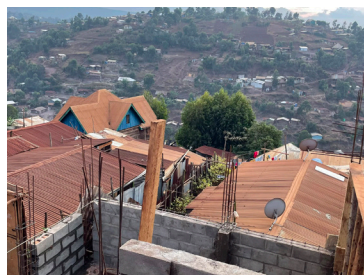
Blick auf die Baustelle der Schulküche
