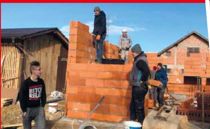
Mit dem beschafften Baumaterial wird der Wiederaufbau des Hauses von Familie Monika mit Unterstützung des Fußballvereins in Angriff genommen.
